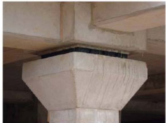
钢筋混凝土框架结构隔离支座，10Hz
